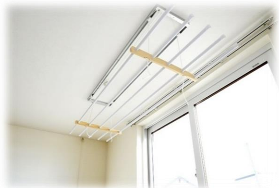
吊り揚げ式洗濯干し
